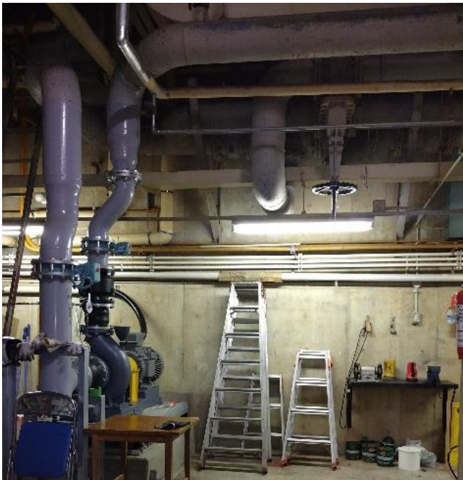
地下2階機械室上部
