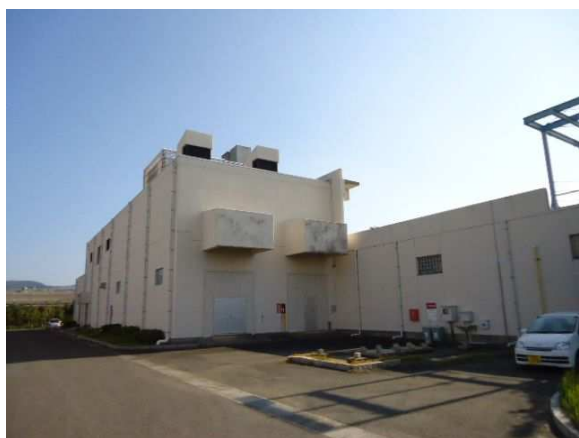
写真-3 西部下水処理場水処理施設
