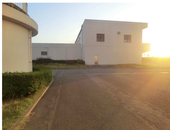
写真-4 西部下水処理場塩素混和池棟
