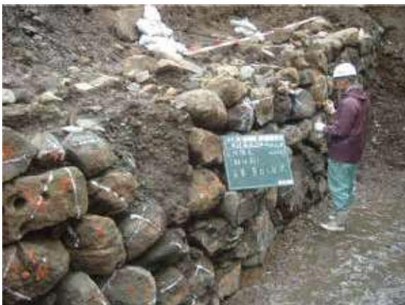
解体時墨打ち作業
