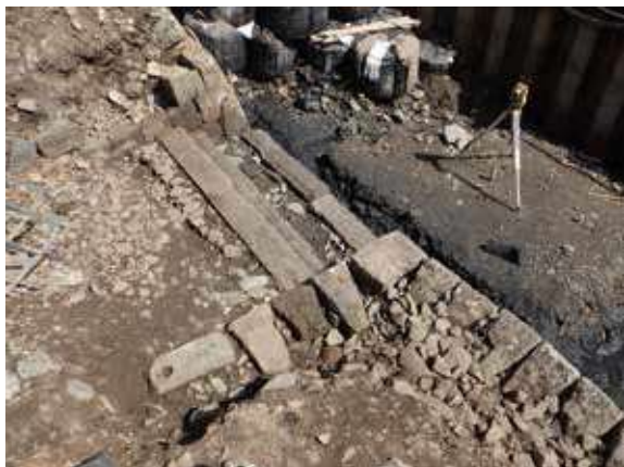
同 6 工区 明治期石段・側壁裏込め
