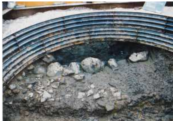
慶応 3 年築足石垣 (H16 年度調査 KO6 地点、市道下検出)
