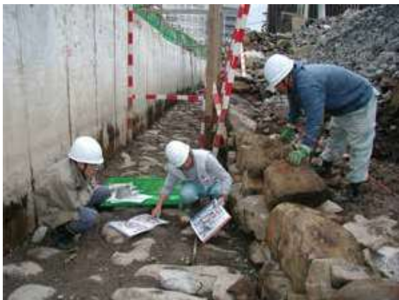
積み直し状況
