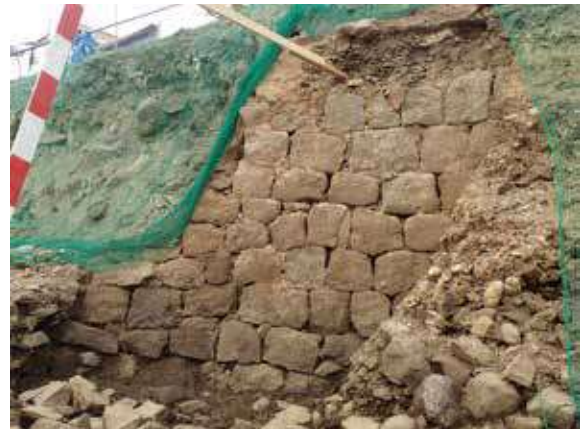
同石垣 正面から
