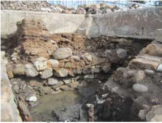
④護岸石垣3-1(TP3)
