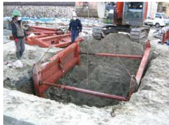
中央部深堀りトレンチ調査(北から)
