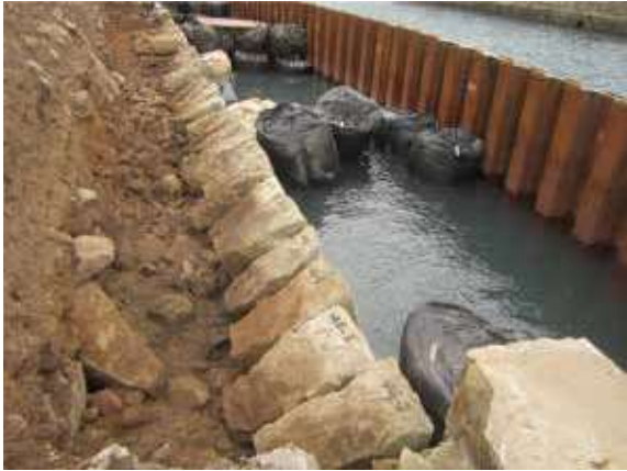
護岸石垣調査 1 工区 明治期護岸石垣 6 段目検出
