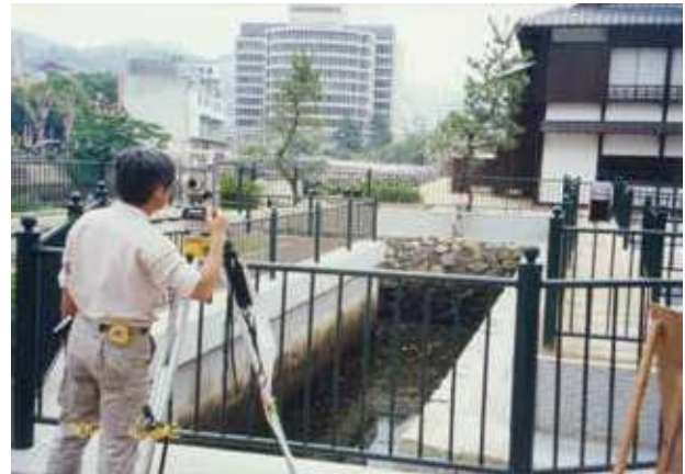
西側護岸石垣復元
