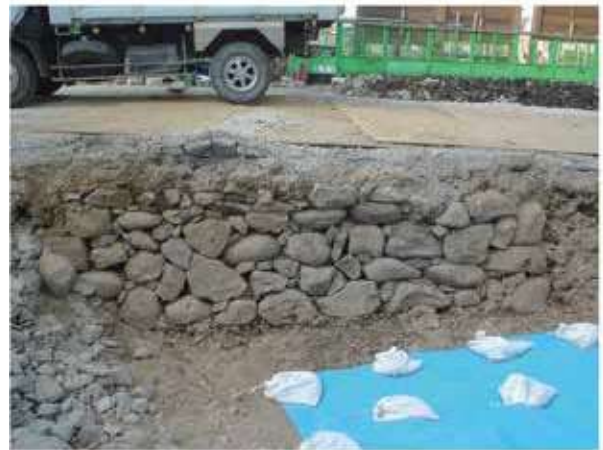
石積東側(平成 17 年度撮影)
