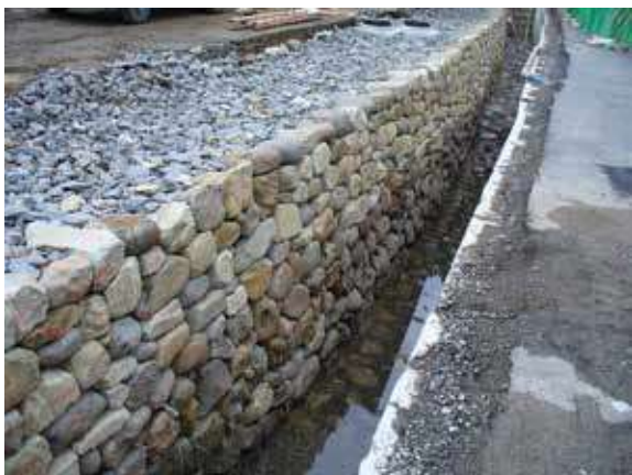
南側護岸石垣復元完了
