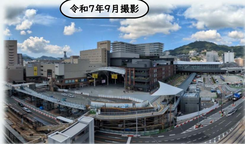
③工場から橋桁が運び込まれ、歩道橋が仮組みされています。
