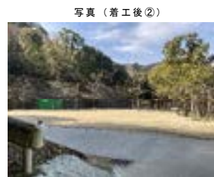
写真（着工後②）
