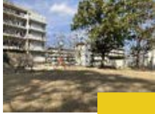
写真（着工後①）
