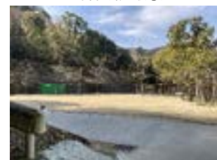
写真（着工後②）
