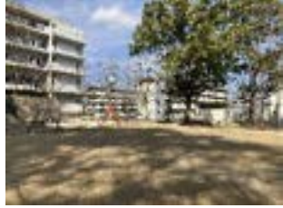
写真（着工後①）
