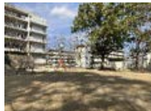
写真（着工後①）
