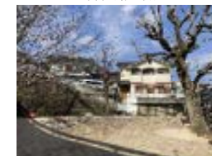
写真（着工後②）
