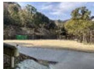
写真（着工後②）
