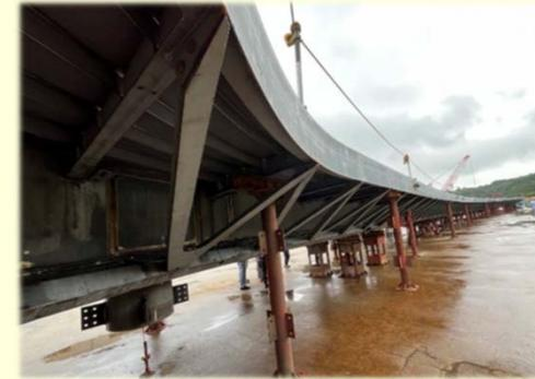
工場で、分割されて製作された主桁を仮組み(部材や部品との調整、または点検のために行なう組み立て作業)したときの様子
