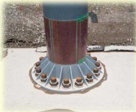
歩道橋の橋脚(支柱)は、56mm~90mmのボルトで締めて、基礎と固定し、その後、周りをコンクリートで固めます。さらに、橋脚の中にもコンクリートを流し込んで強度を高めます。
