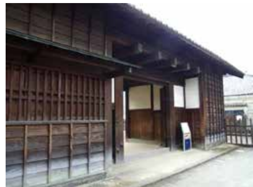
写真6 表門北側外観
