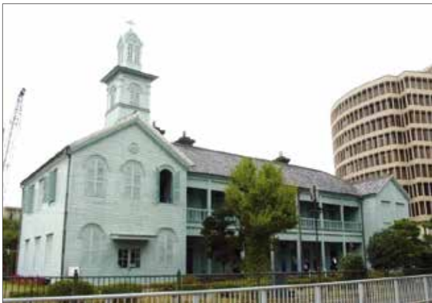
写真 27 旧出島神学校南側外観
