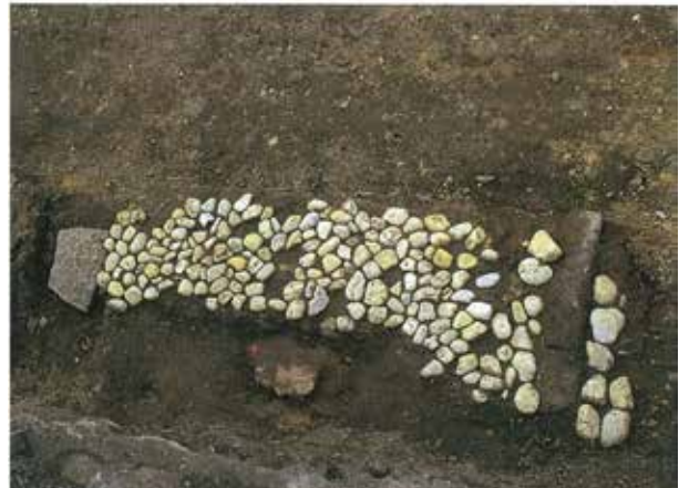
写真74 白玉石を用いた道路舗装面
