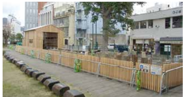
写真 24 芝生広場一角に設置された石材倉庫
