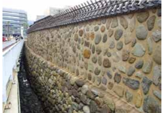
写真 51 南側護岸石垣
