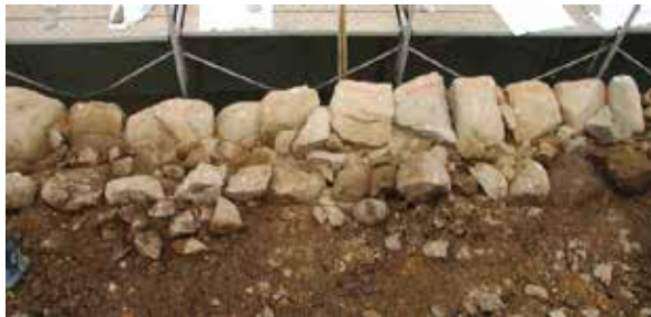
写真 82 石垣解体6段目(裏込め中央部)
