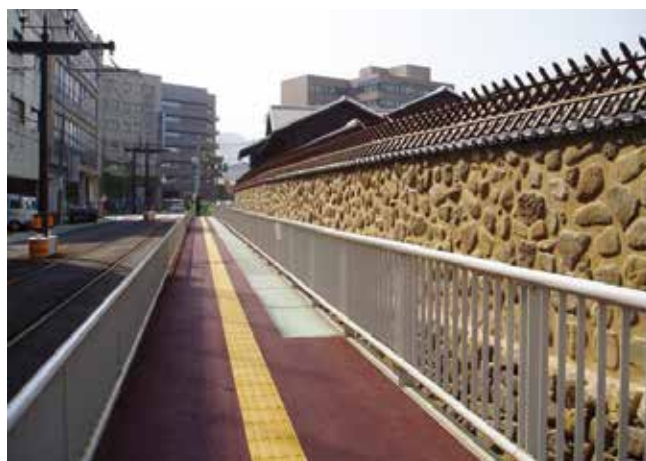
写真 85 練塀と見学用歩道の整備
