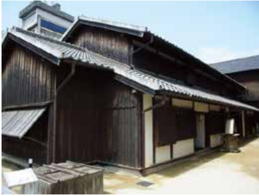
写真 42 乙名部屋北東側外観
