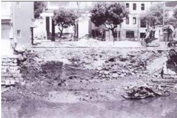
写真 80 No.1-② 明治石垣崩落による解体
