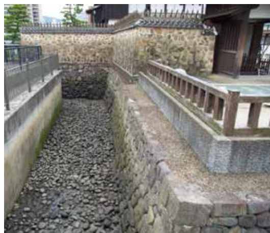
写真52 西側石垣復元状況
