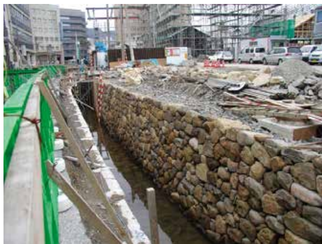
写真 84 修復された南側護岸石垣
