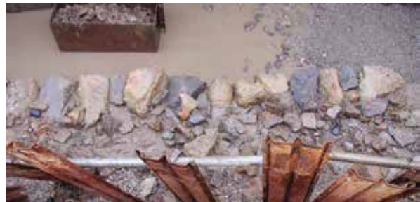
写真 83 石垣解体4段目(裏込め下部)
