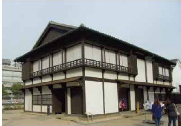
写真31 一番船船頭部屋南西側外観
