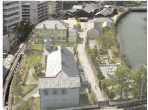
写真7 出島中央道路(東側より)
