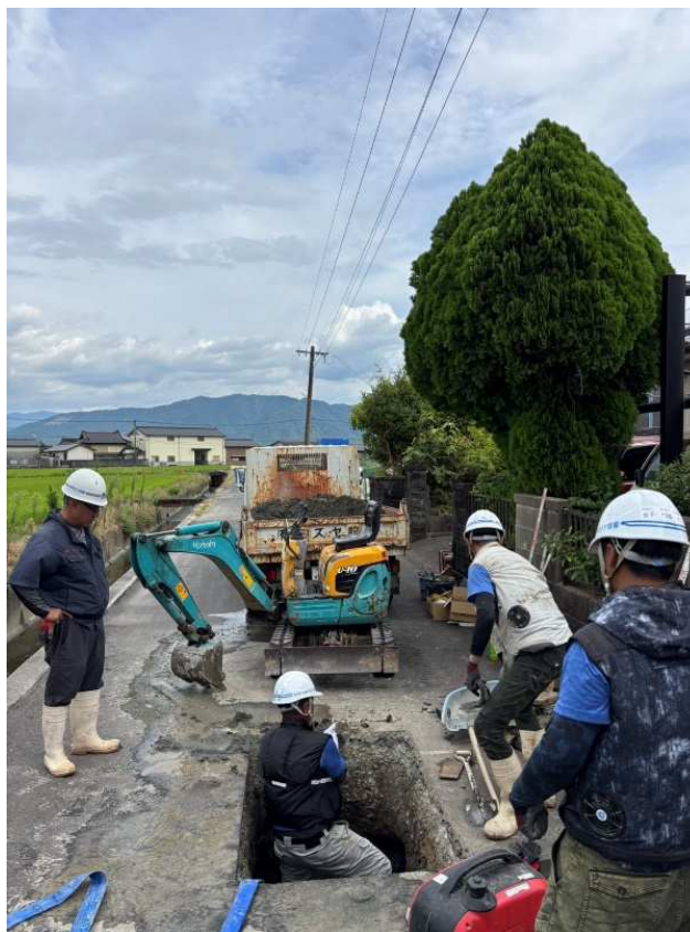
応急復旧作業②
