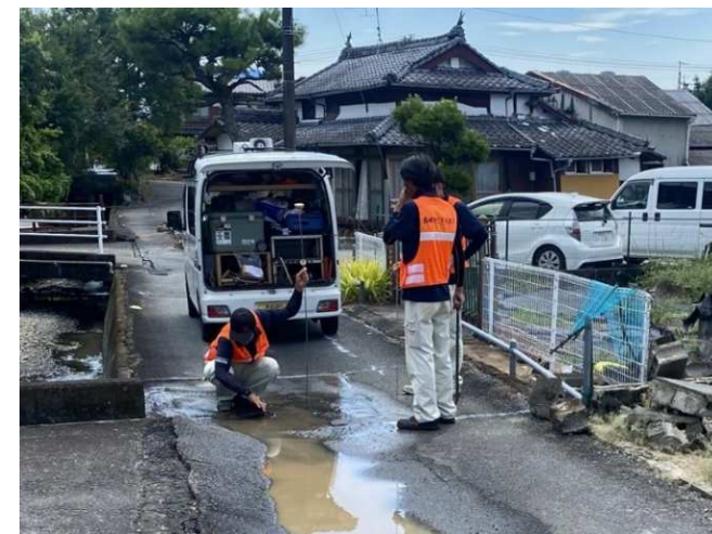
漏水調査作業②
