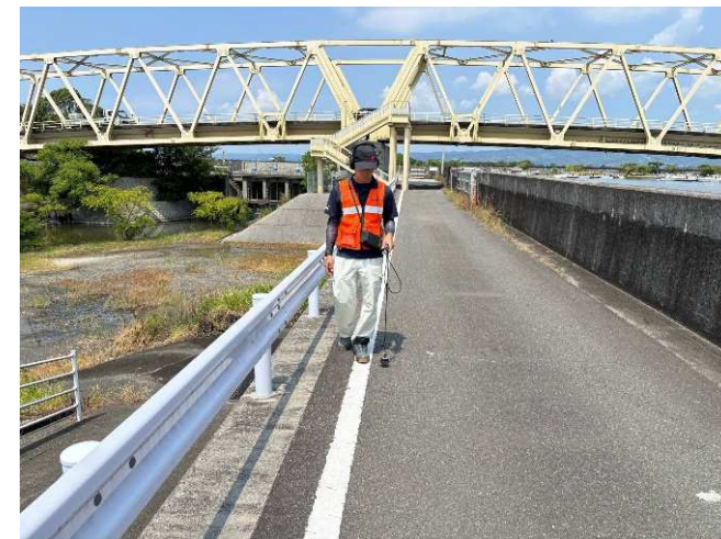
漏水調査作業①
