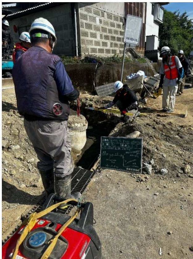
応急復旧作業①
