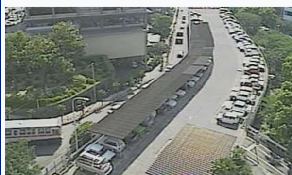
①改修前の駐車場
