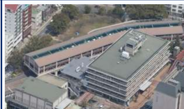
②改修後の駐車場
