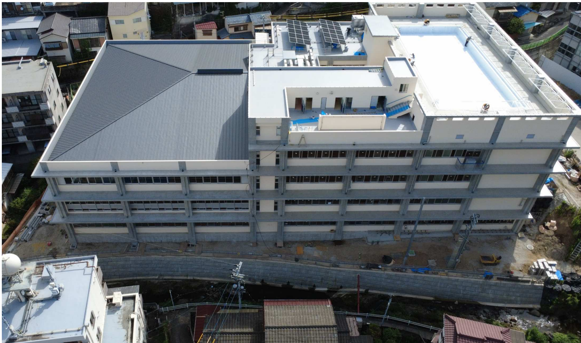
R8. 7. 30時点 現場状況写真
