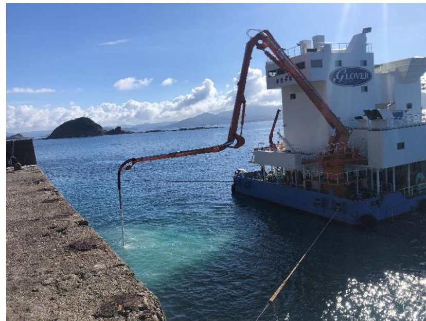
(ア) 端島護岸補強整備工事
