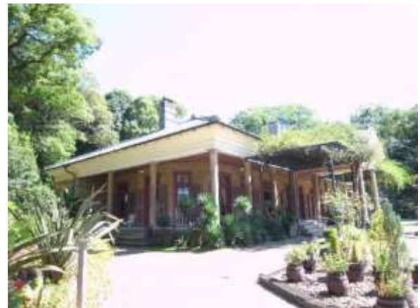
— 旧オルト住宅 —
