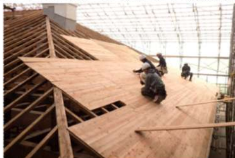
重要文化財旧オルト住宅の耐震補強工事の様子
