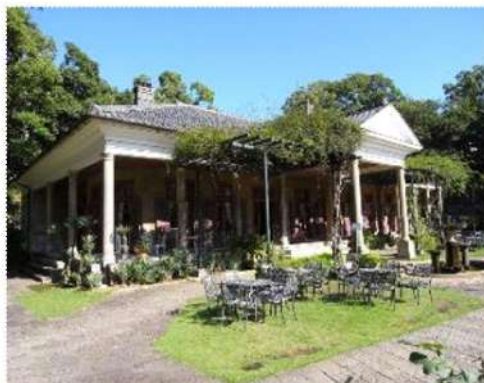
重要文化財旧オルト住宅R4年度～R8年度の5か年で耐震補強工事を実施予定
