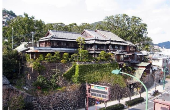
平成 30 年に解体された料亭富貴楼
