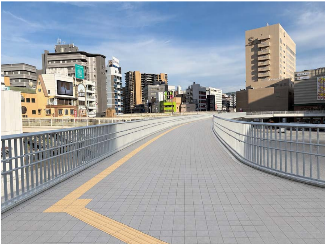
長崎駅東口・駅前第四歩道橋
