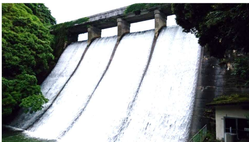
浦上ダム堰堤
