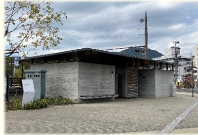
多目的トイレ整備 (H28 出島表門橋公園便所)
