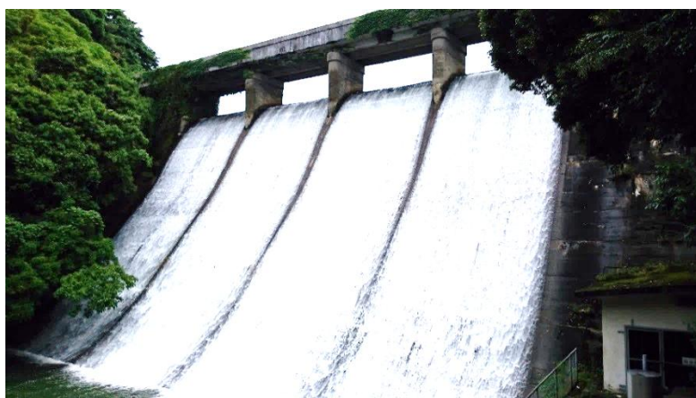
浦上ダム堰堤
