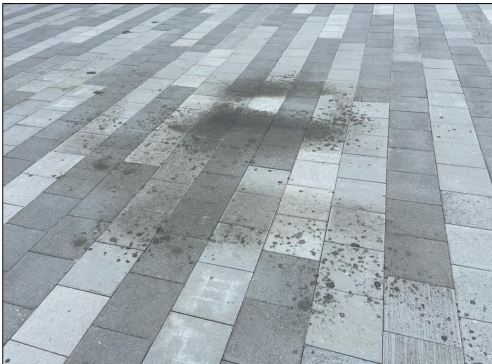
写真-清掃前(舗装の汚損)
