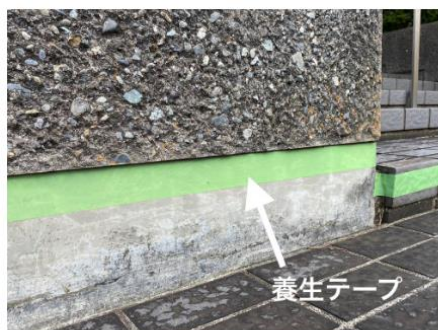
例：壁面に養生テープを貼付け
