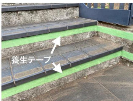
例：階段に養生テープを貼付け
