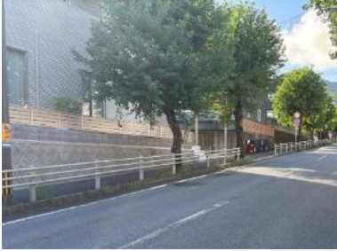
【ガードパイプの設置（市道滑石横尾線）】
