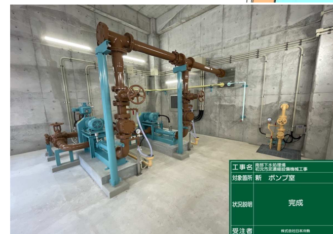
完成（新濃縮棟ポンプ室）
