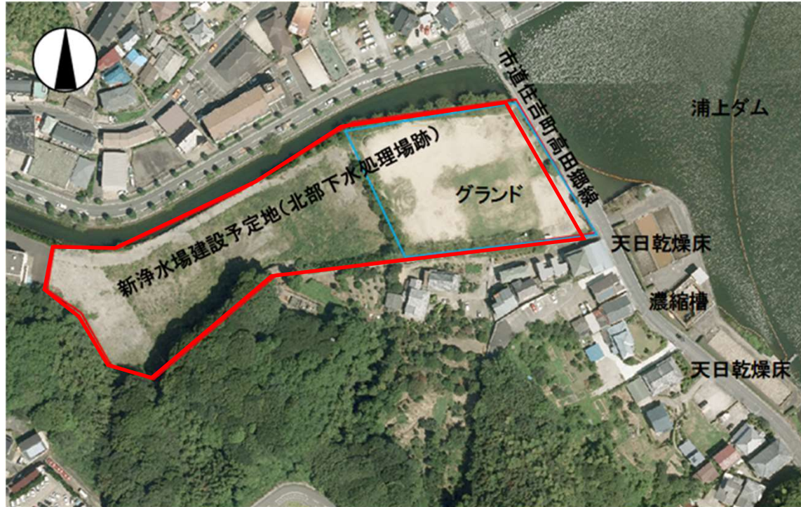
新浄水場建設予定地
