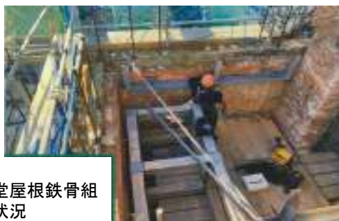
本館屋根母屋材取付作業状況
