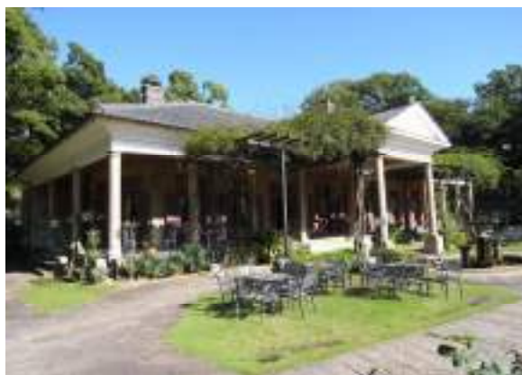
重要文化財旧オルト住宅 令和4年度～7年度の4か年で耐震補強工事を実施予定
