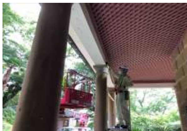
重要文化財旧オルト住宅の耐震診断の様子。
