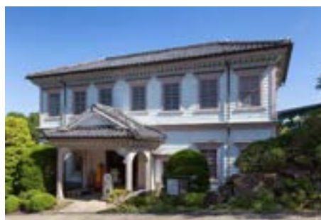
旧長崎地方裁判所長官舎(R6年度耐震工事完了)
