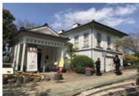
旧自由亭(R7年度耐震工事予定)
