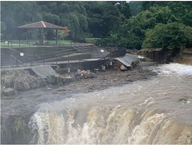
姶良市加治木地区の被害状況
