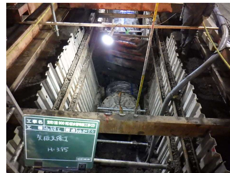
矢板設置状況
