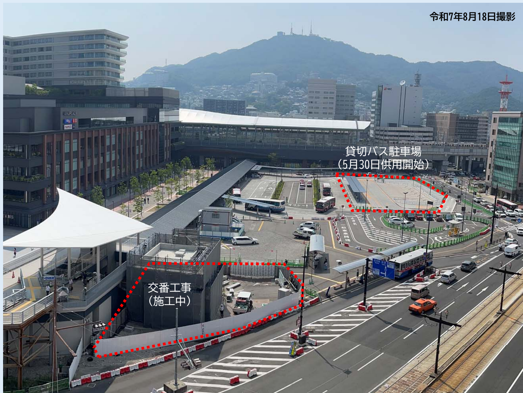
現況写真（東口交通広場）
