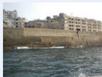
コンクリート護岸
