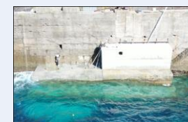
施工中の護岸
