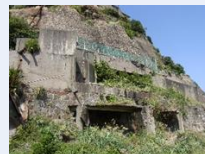
コンクリート擁壁
