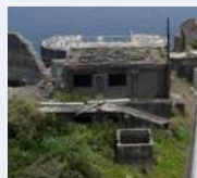
ブロワー機室
