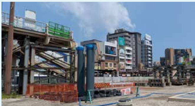
歩道橋(南北接続デッキ)工事の様子
