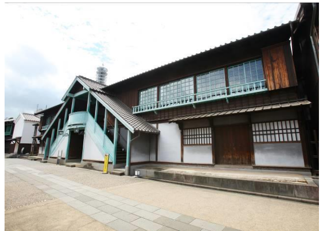
—カピタン部屋外観—
