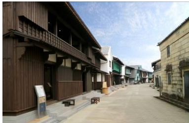
—復元された出島のまちなみ—
