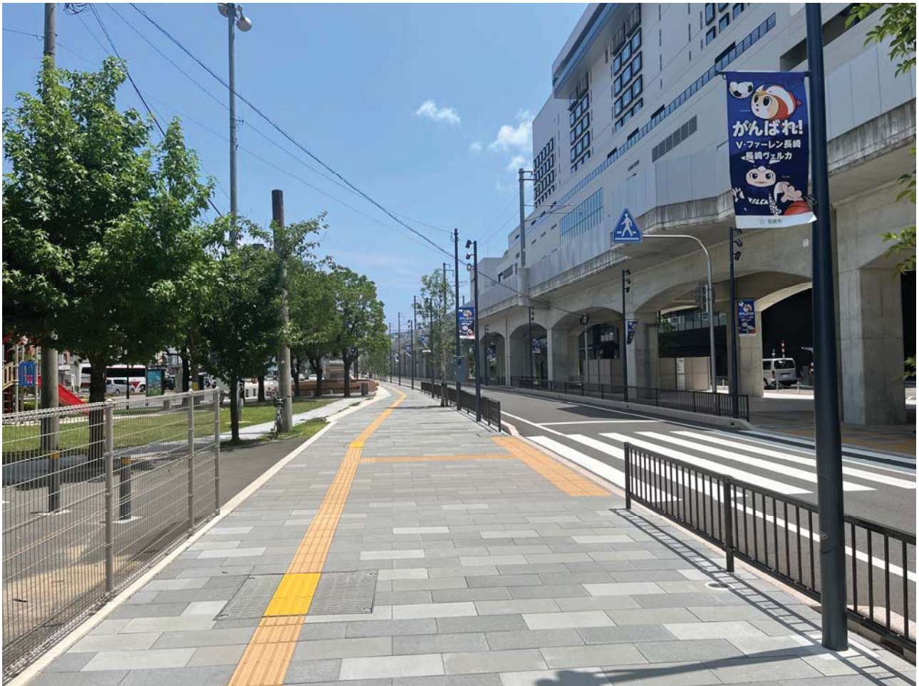
都市計画道路長崎駅東通り線（写真中央）と 都市高速鉄道 九州旅客鉄道株式会社長崎本線（写真右）
