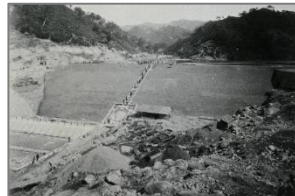
完成当時の本河内高部ダム
