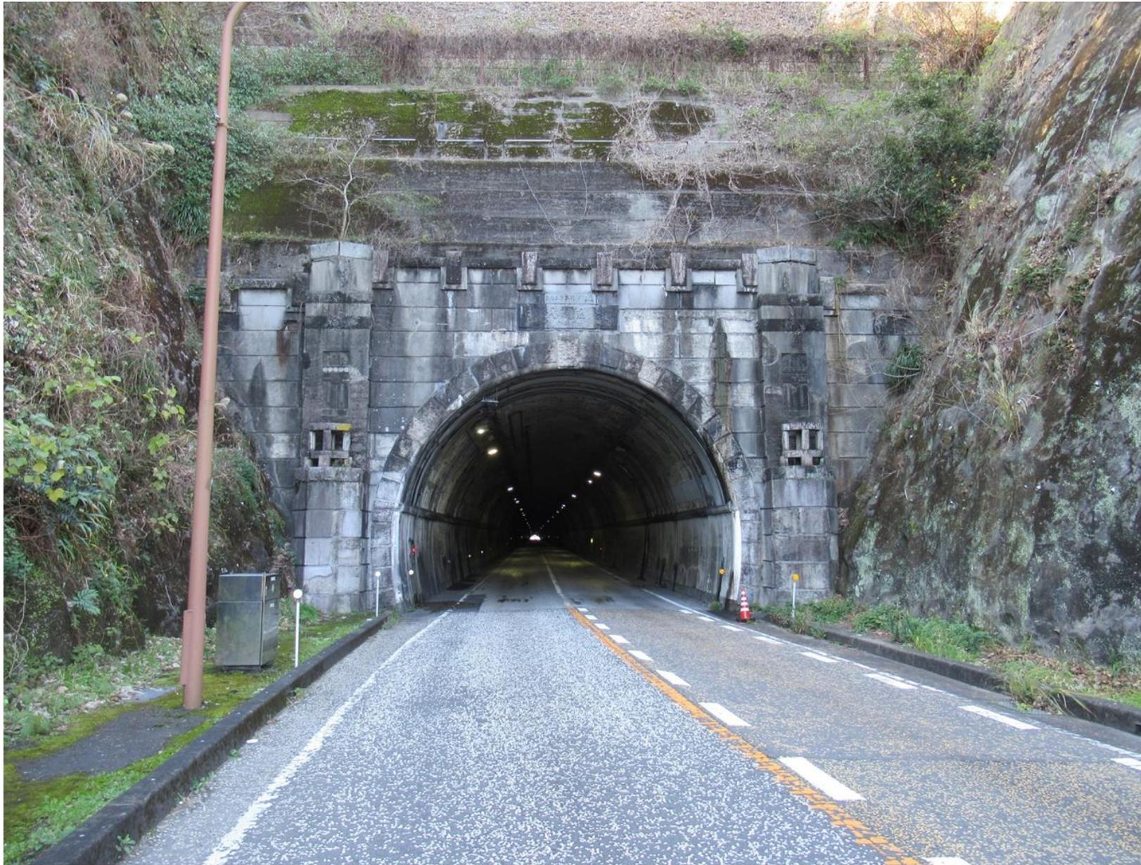
日見トンネルは、県が大正13年(1924)に着工し、2か年で完成しました。全長642m幅員7.4mは当時日本最大規模。坑口のデザインは大正期の様式を色濃く残しており、平成14年(2002)に国の登録有形文化財になりました。
