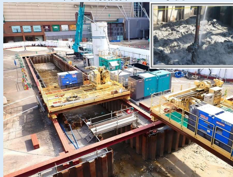
高圧噴射攪拌工法の事例
