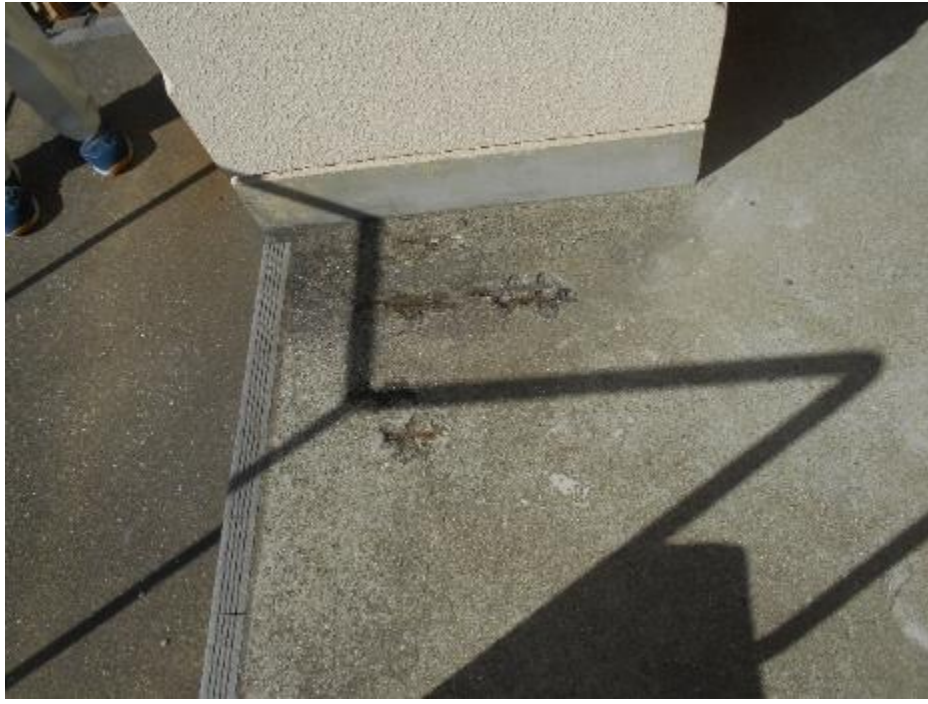
①ホテル(土間の鉄筋爆裂)
