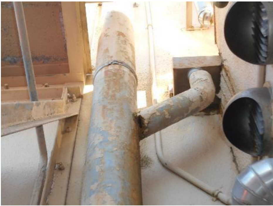
①ホテル(雨水排水管腐食)
