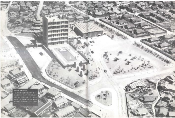
写真－1 長崎国際文化会館（昭和 30 年 2 月完成） 出典：長崎市政 20 年の歩み
