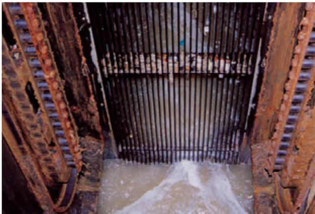
**細目スクリーン** 汚水と共に流入してきたゴミをくし状のスクリーンで取り除きます。
