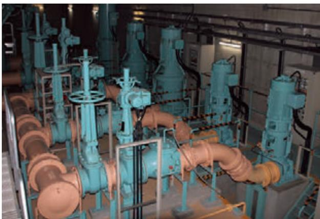
**主ポンプ** 自然流下で地下深くに流れてきた汚水を水処理施設へくみ上げます。
