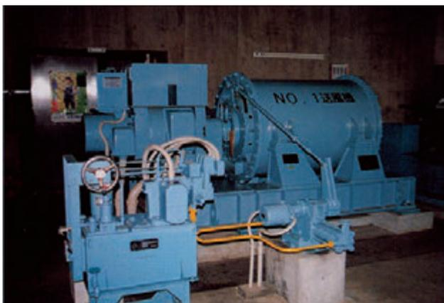
**送風機** 微生物の力で汚水を浄化する反応槽へ、微生物の呼吸用の空気を送り込みます。
