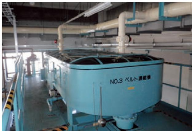
**機械濃縮装置** 汚水が浄化されると、汚れの成分が集められた下水汚泥が発生します。処理場では機械濃縮装置に下水汚泥を投入して重力の作用により過濃縮して、脱水装置を効果的に機能させるよう水分の減少を行っています。
