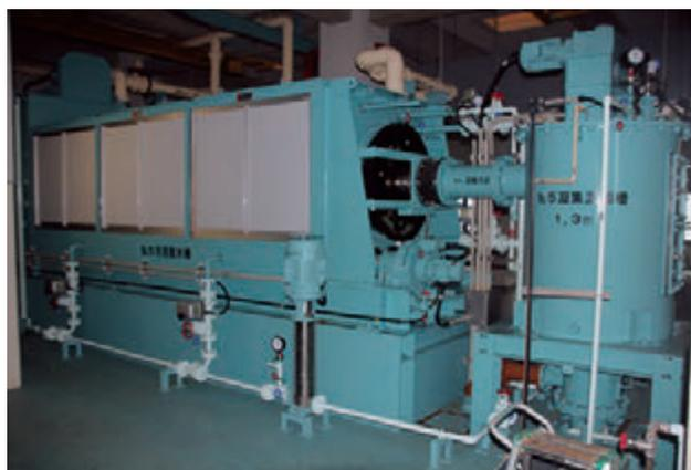
**脱水装置** 濃縮された下水汚泥は、脱水装置によりさらに水分を減少させて脱水ケーキと呼ばれる汚泥として、コンポスト処理や焼却処理施設へと引き渡します。コンポストなどに生まれ変わった下水道汚泥は、肥料などとして有効利用されています。
