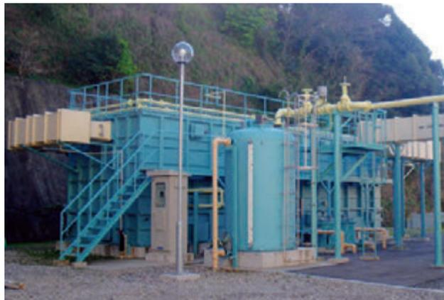
**脱臭装置** 汚水が集められると硫化水素のような不快な臭いも発生します。不快な臭いは脱臭装置に送られ、臭気が分解されます。
