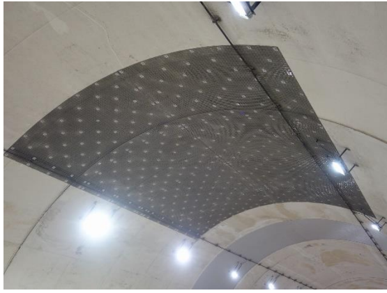
はく落防止対策（FRP メッシュ）
