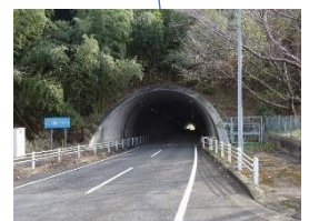
7. 矢上団地トンネル L=292m
