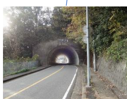
5. 水の浦トンネル L=60m
