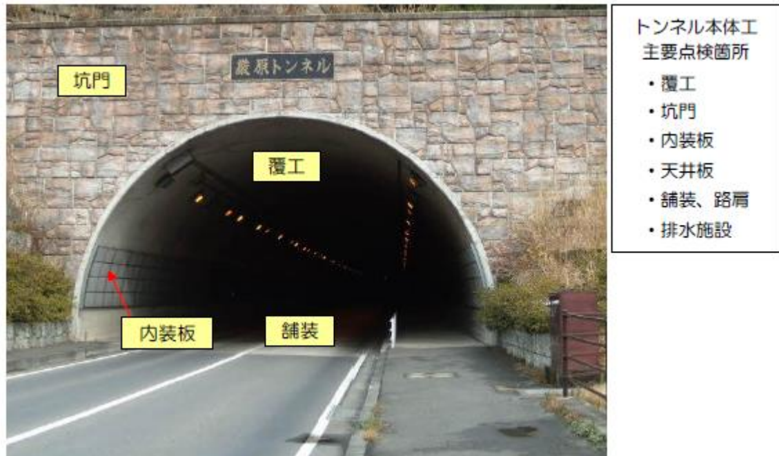
道路トンネル本体工の概要図
