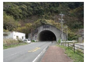
1. 運動公園トンネル L=934m
