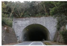
8. あぐりトンネル L=175m
