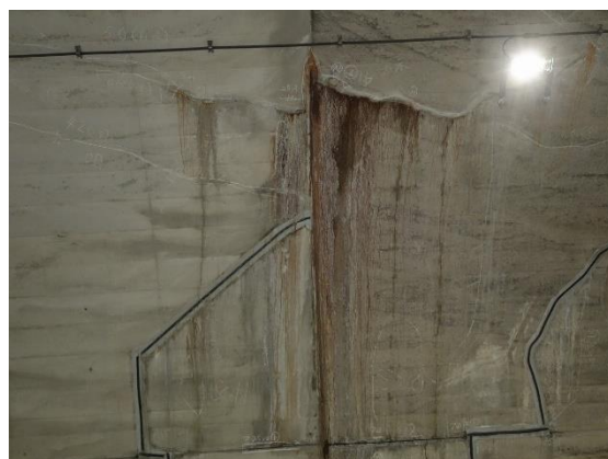
覆工コンクリートのひび割れ沿いの漏水 (矢上団地トンネル)
