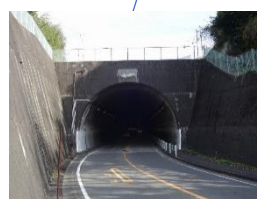
2. 長崎卸トンネル L=206m
