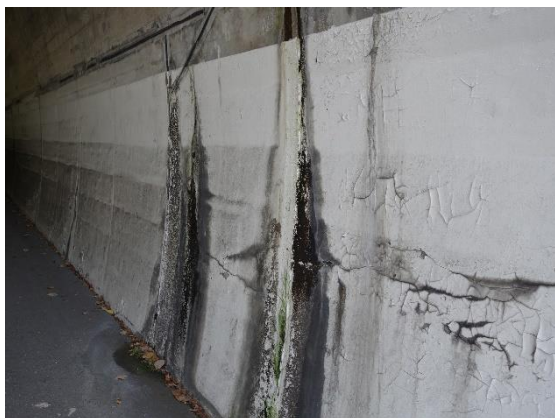
覆工コンクリート打ち継ぎ目からの漏水 (長崎卸トンネル)
