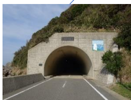
9. 乗越トンネル L=286m
