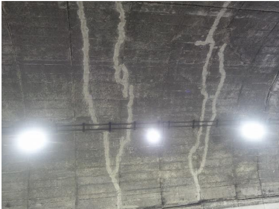
ひび割れ対策（ひび割れ注入工）
