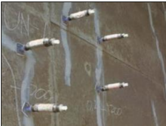
はく落防止対策（ひび割れ注入工）
