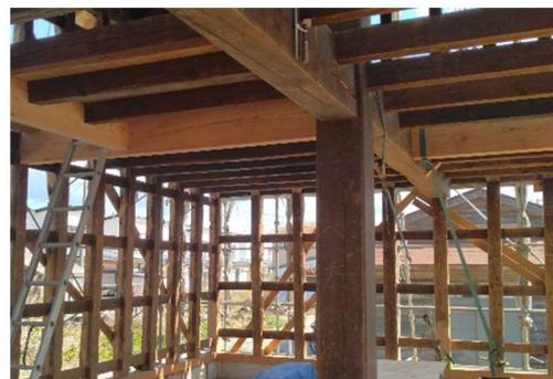
貫工法施工例 1 (写真 12)
