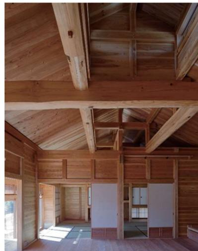
片面真壁造の落とし込み板壁（写真9）
