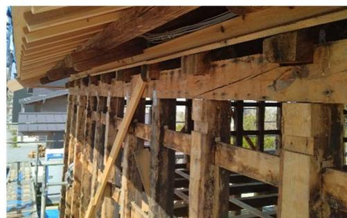
貫工法施工例 2 (写真 13)
