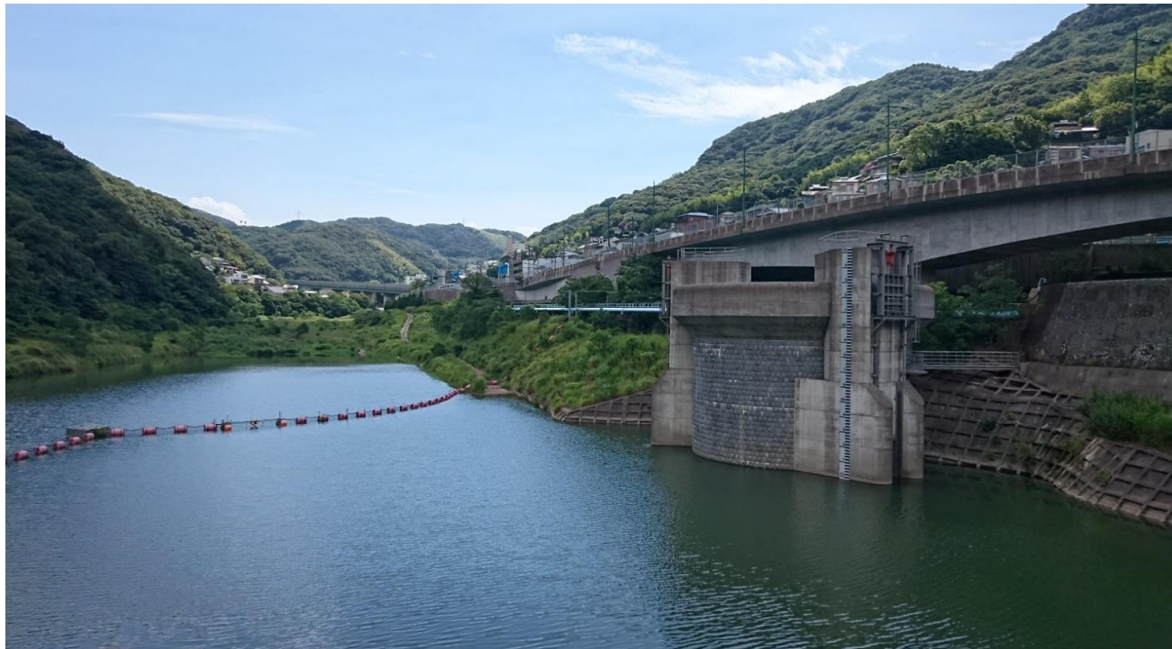
本河内低部ダム取水塔
