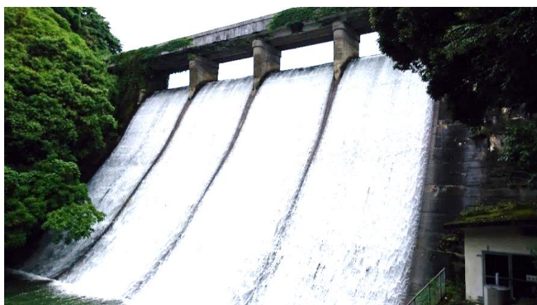
浦上ダム堰堤
