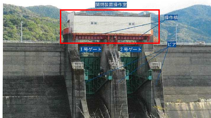
神浦ダム洪水吐ゲート全景
