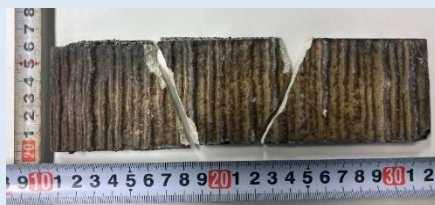
落下したタイル
