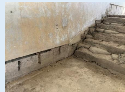
3階～塔屋の階段部 (未整備)
