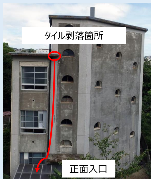
旧城山国民学校校舎南側
