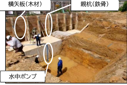
地盤面下の工事状況 令和6年7月から9月頃
