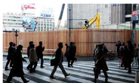
▲ 工事仮囲いの工夫例(東京都)
