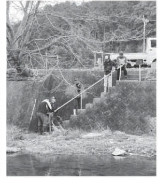
安全のための手すりを確認
