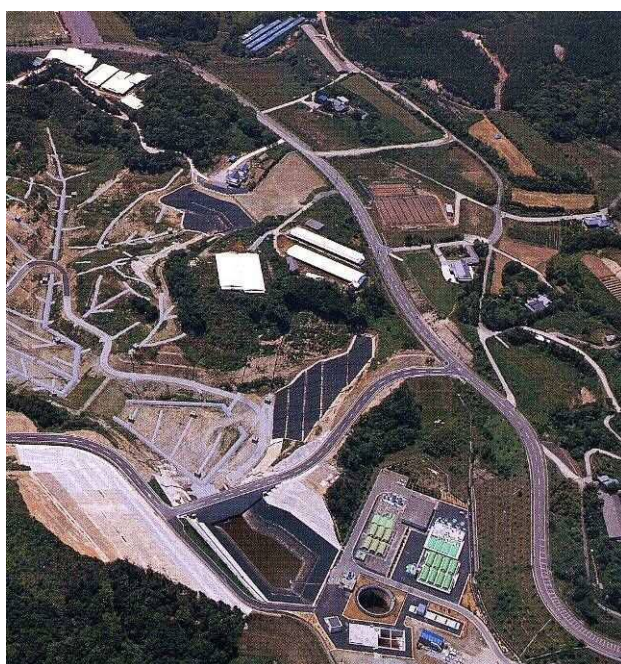
三京クリーンランド埋立処分場
