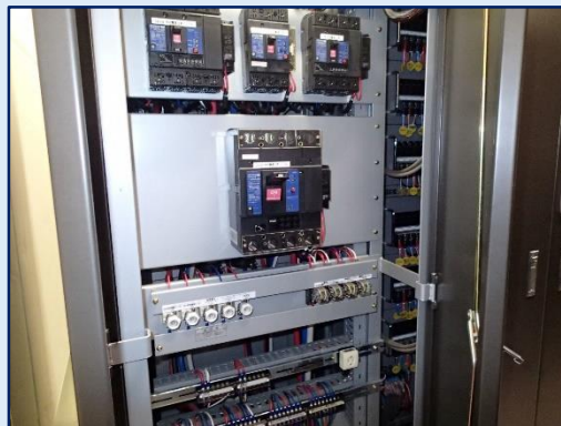
調光分岐盤内部(分岐主幹)
