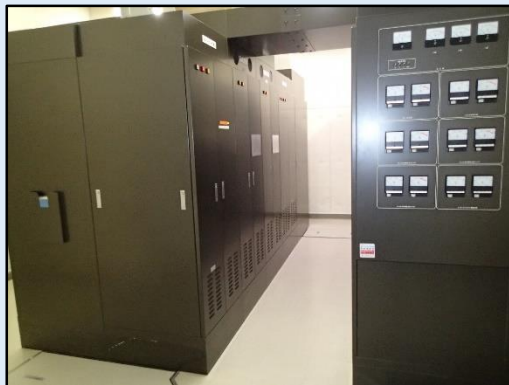
調光主幹盤、調光分岐盤、調光器盤
