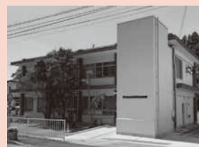
▲手熊地区ふれあいセンター
