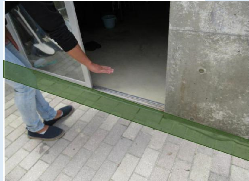
入口付近に水が溜まる為、雨水排水用側溝新設 4箇所
